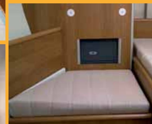
A sinistra, particolare della sentina dove si vede il controstampo semistrutturale. In basso a sinistra, retro del pannello portastrumenti. Sotto, dettaglio della cabina armatoriale
