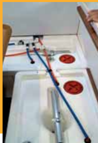
Sotto, i serbatoi dell'acqua che compongono la base dei divani. Le barre di ferro servono a serrarli al pagliolo
